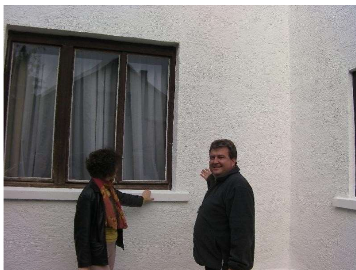
13. Fotó: TSM Ceramicel lefújott műkö párkányok 2013.október
