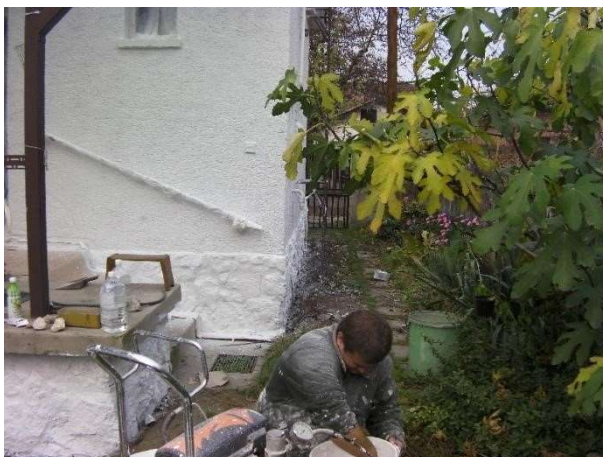
7. Fotó : Lábazat kivitelezés közben 2013.október
